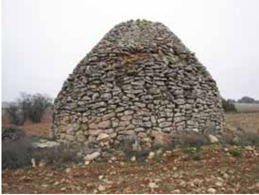
La forma de construir la cúpula de la calera era similar a la construcción de chozos. El Gordito. Jorquera
