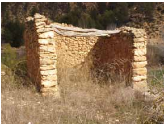
Fábrica de piedra tosca. Cantos redondeados. Cinco casas, Villamalea.
