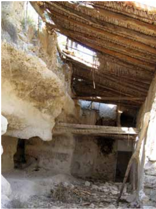
Entrevigado de cañizo. Casa apoyada en la montaña. La Recueja
