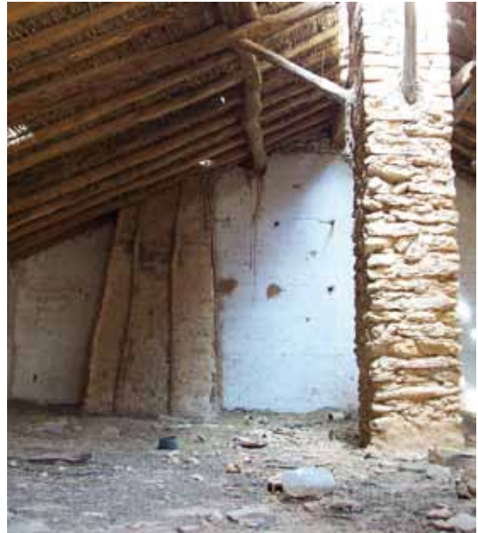
Solado de tierra compactada. Aldea de los Nuevecillos. Término de Alarcón
