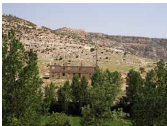
Vista desde la antigua central hidroeléctrica
