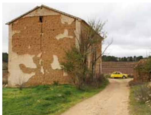
Casa de Gabaldón. Término de Villalpardo. Espectacular tapia de unos once metros de altura
