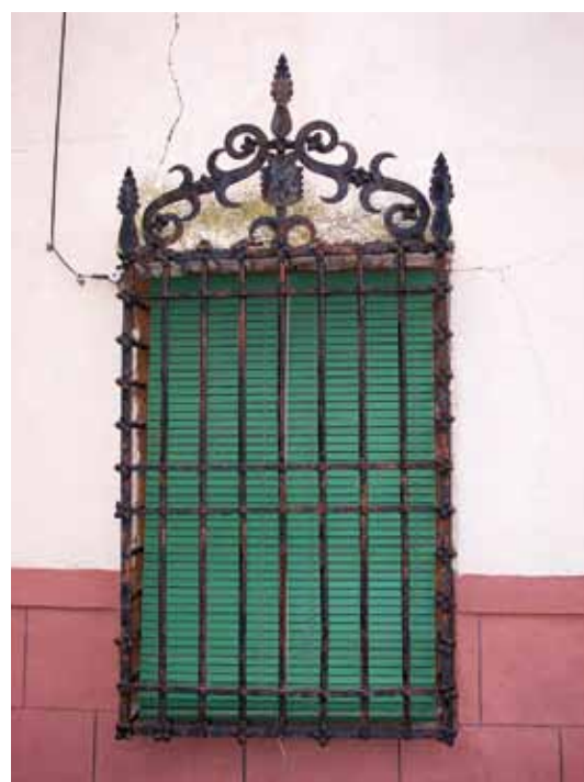
Reja de ventana. Rubielos bajos
