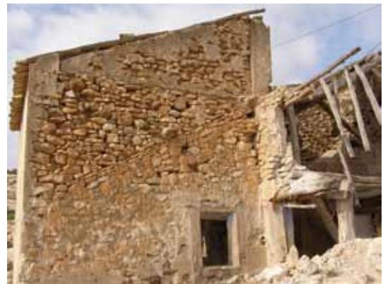
Muro de mampostería. Sobreelevación posterior. Aldea Puente Torres.
