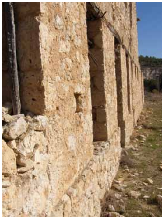
Cerramiento de mampuestos sobre zócalo del mismo material. Casa de la Central Eléctrica. La Recueja
