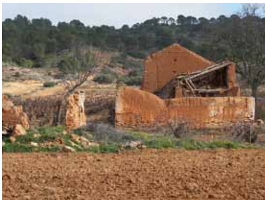
Tapia apoyada sobre zócalo de mampuesto. Casa de Petra Collado. Casasimarro
