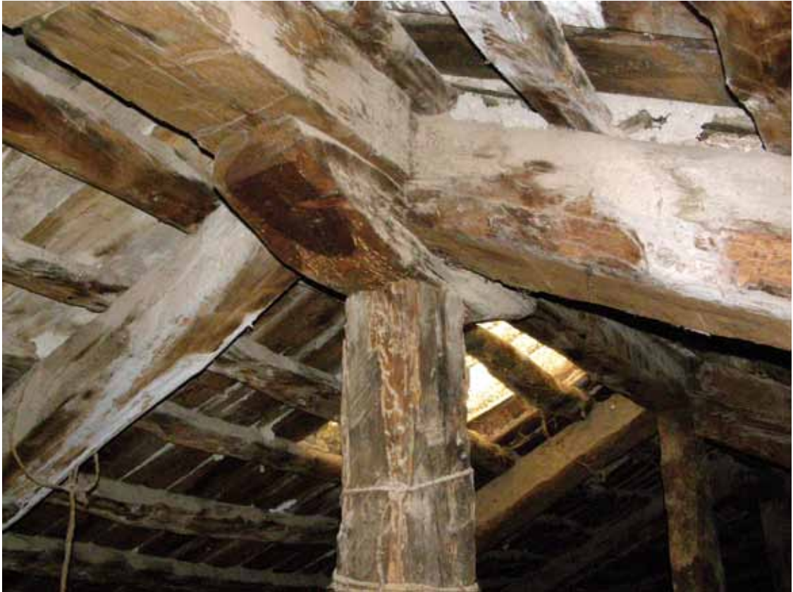
Estructura de cubierta. Venta del Pesquete. La Pesquera
