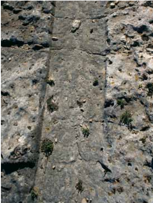
Calzada medieval. Nº 15
