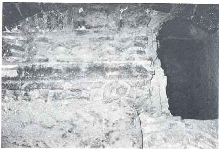
Fot. 19b.— Detalle del muro mudéjar de la torre. (Vid, Esquema 2, muro "A").
