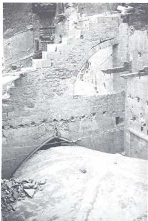
Fot. 8.— Arbotante gótico sobre la nave del Evangelio. Obsérvese el vértice del arco apuntado oculto por las bóvedas barrocas. (Vid. sección) Foto durante las obras de 1980.
