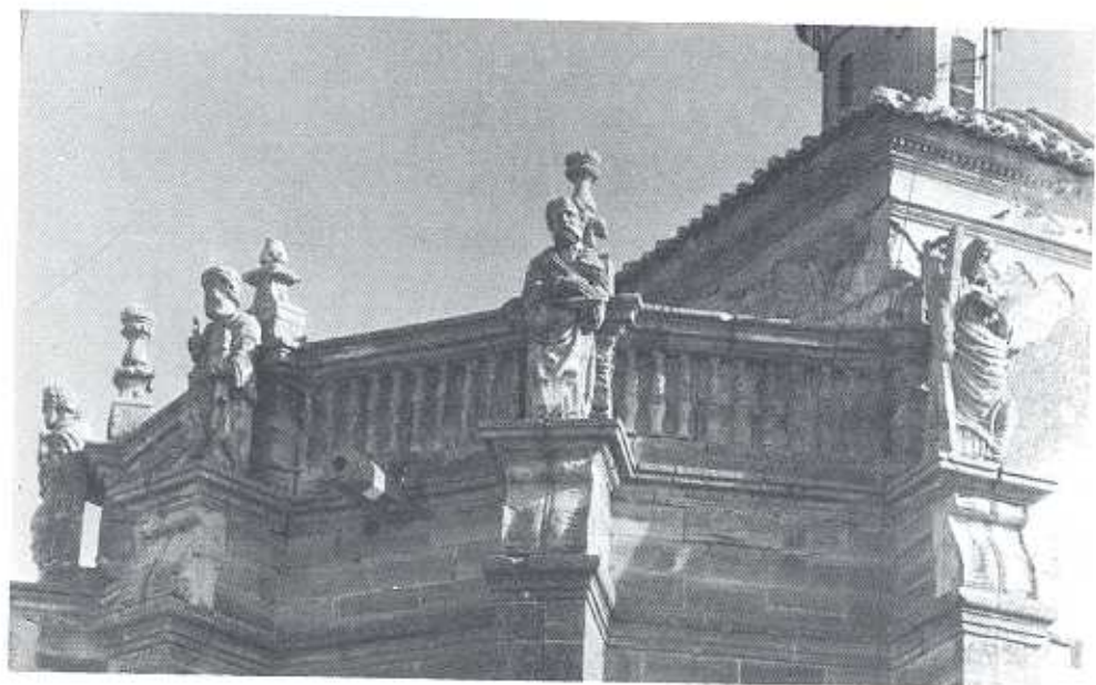
Fot. 27.— Remate ábside, balaustrada y santos.
