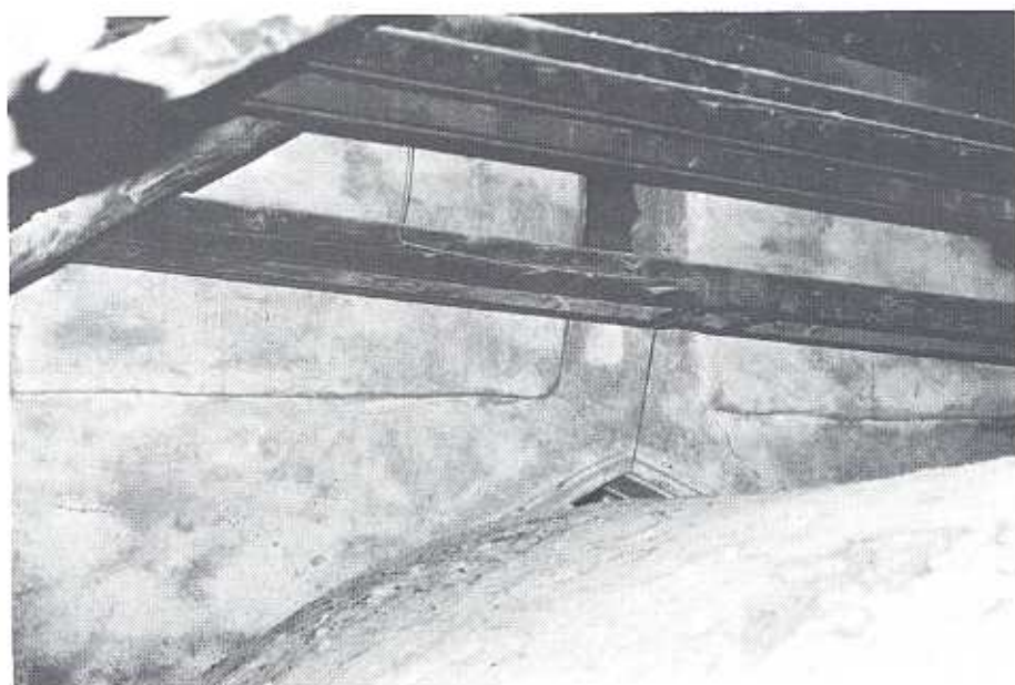
Fot. 10.— Tirantes mudéjares en la nave central. Obsérvese el vértice del arco apuntado oculto por la bóveda barroca; sobre él, pequeña ventana que iluminaba por el Este la nave central situada en el testero que por su forma de trapecio recordaba la sección de la cubierta de madera. (Fot. antes de la destrucción del testero por la restauración de 1980).
