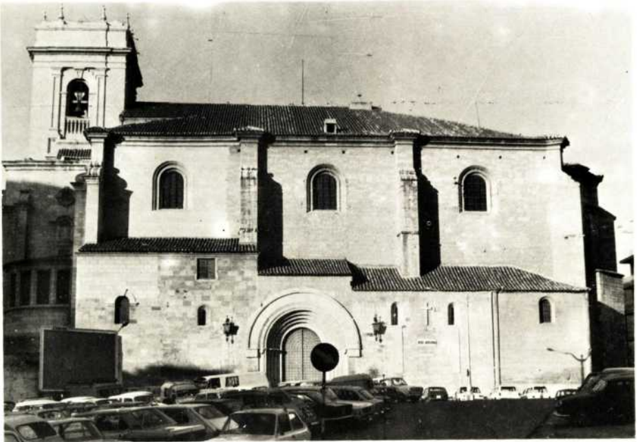
FOT. 11— ALBACETE. San Juan Bautista. Fachada Sur. Estado actual, con la obra moderna a la izquierda.
