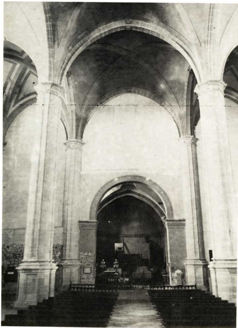
FOT. 5— VILLARROBLEDO. Interior hacia los pies. Tramos segundo y tercero. Al fondo, la obra cortada.
