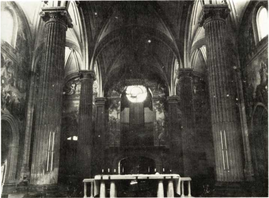
FOT. 15-ALBACETE. San Juan Bautista. Interior desde la cabecera.
