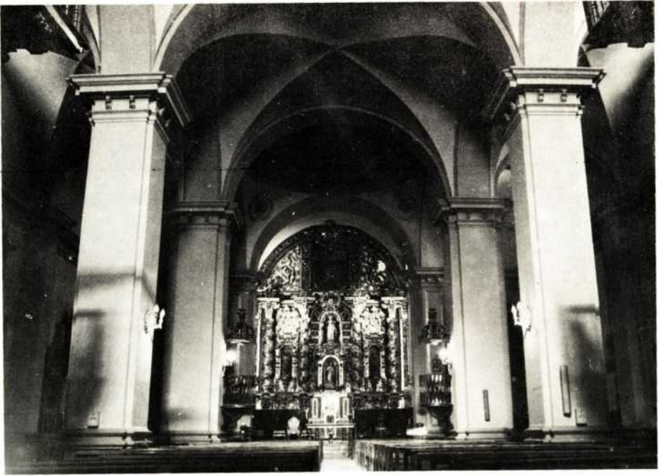
FOT. 6 — EL BONI LLO. Iglesia de Santa Catalina. Interior.
