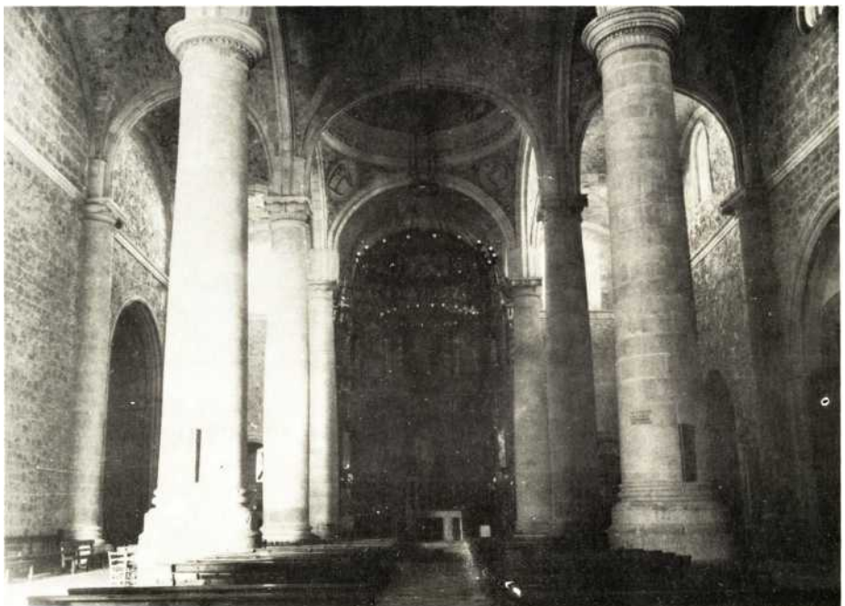
FOT. 2— LA RODA. Interior hacia lá cabecera.
