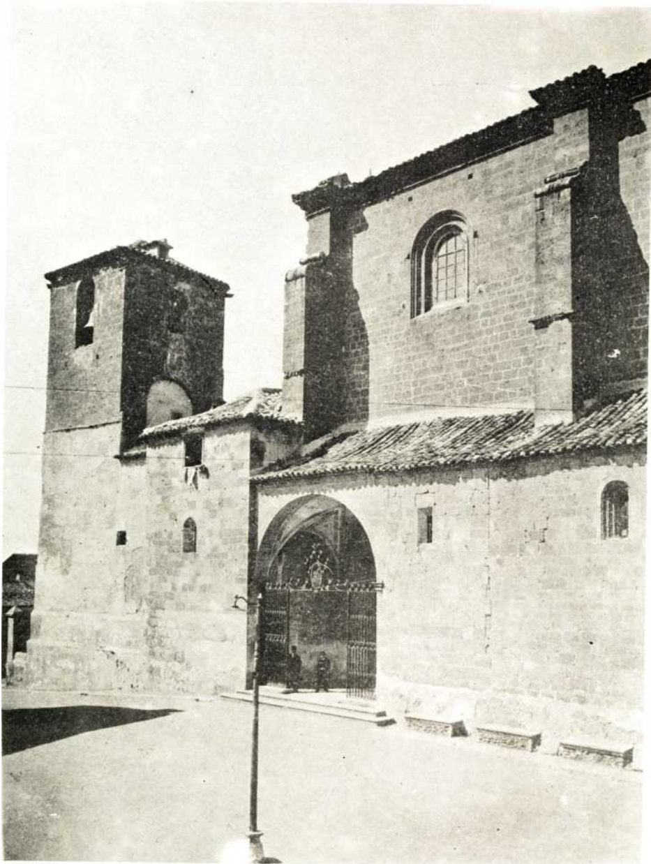
FOT.10- ALBACETE. San Juan Bautista. Parte Sur. A la izquierda observese parte de la obra primitiva. El primer cuerpo de la torre de tapial el segundo de silleria. (Fot. del Roa)
